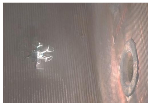
ボイラ炉内点検画像
